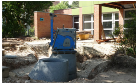
Die Generalsanierung am Babenbergerring geht voran.
