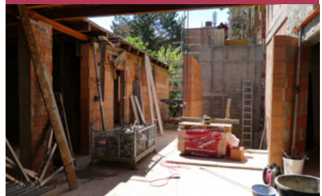
Der neue Eingangsbereich nimmt Form an.
